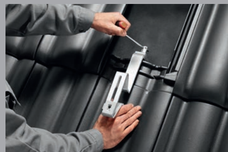
Crochet réglable pour le montage surtoits inclinés.
